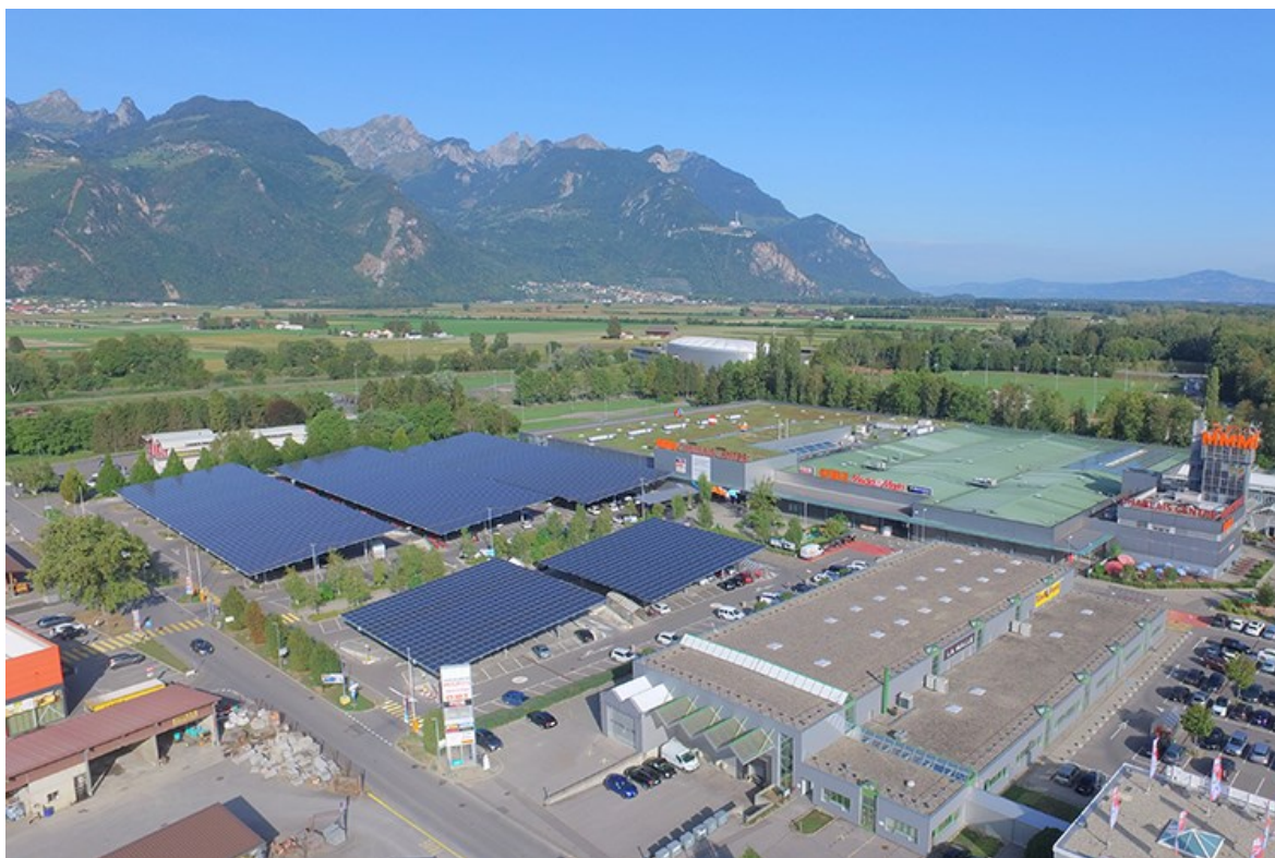
Figure 25: ombrières photovoltaïques dans la zone commerciale d'Aigle (Romande Energie)
